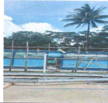
Foto 4: Se evidencia la estructura de cada una de las aulas del Establecimiento Educativo.
