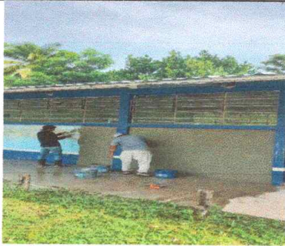
Foto 3: En esta fotografía muestra el repello de las paredes en la parte de afuera de las aulas del Centro Educativo.
